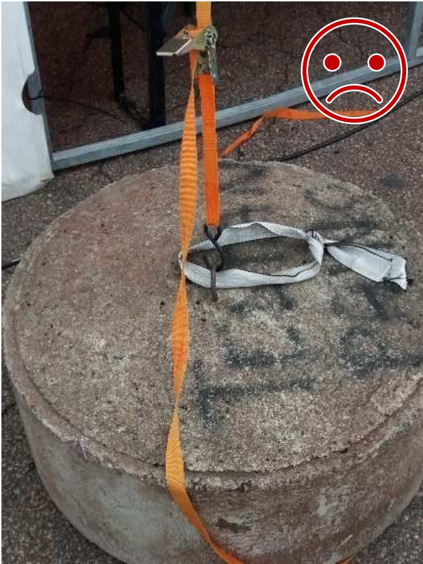
Kuva 7 EI NÄIN. S-koukku ei ole lukittava. Koukku irttaa rakenteen liikutessa.
