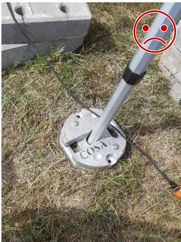
Kuva 1 EI NÄIN. Painojen lukitus toisiinsa puuttuu. Painot irtoavat painovoimaisesti, eivätkä pysy tolpan ympärillä tuulen ravistellessa telttaa.
