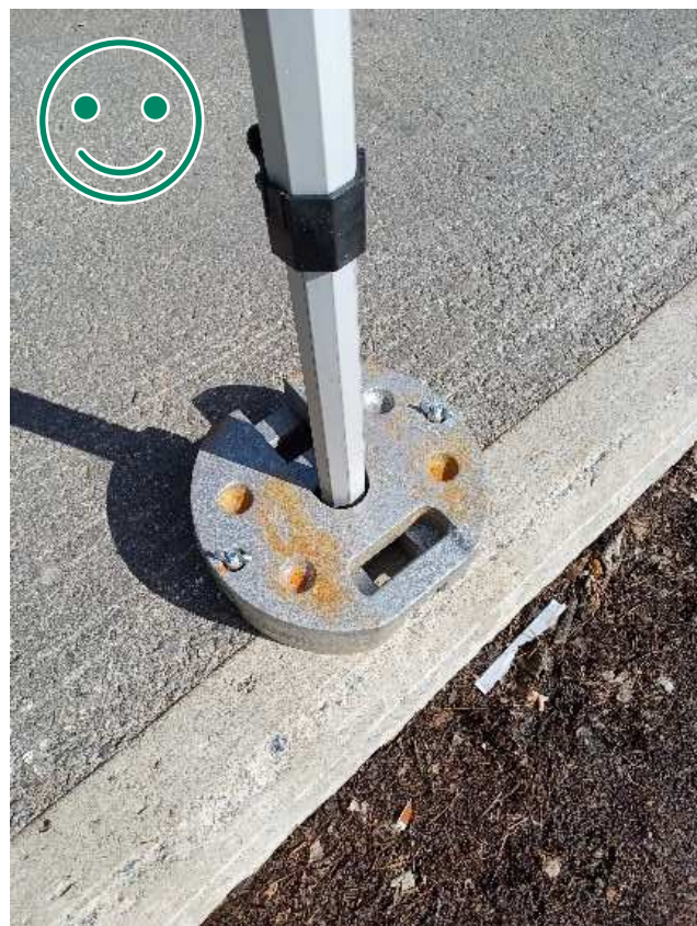
Kuva 2 HYVÄ TAPA. Molemmat painot kiinnitetty siipimutterilla molemmin puolin. Hevosenkäpypainot vastakkain, jolloin tolppa ei pääse irtoamaan rakenteen liikkeessä. Kulmatolpan maajalan tulee kestää kyseinen paino.
